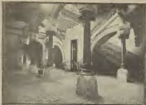
Vestibulo y escalera.
